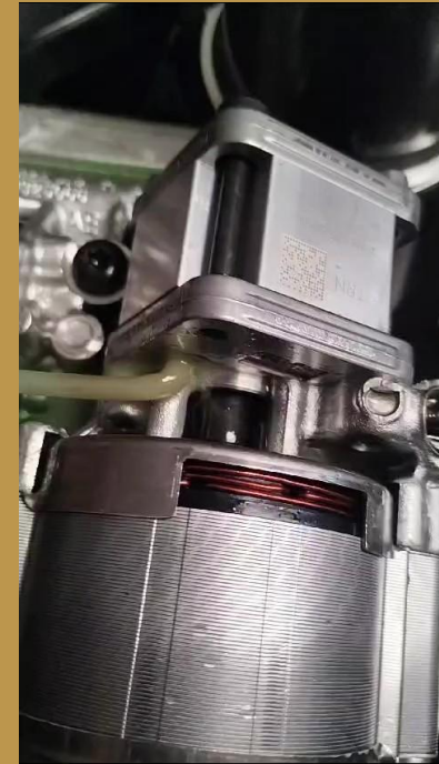
Verificación de funcionamiento de motor eléctrico.
